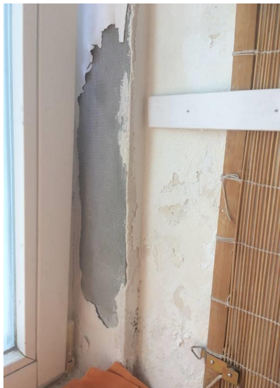
Pravděpodobně při osazování nových oken, bylo na opravu omítek použito cementové lepidlo a perlinka. Povrch se tak zcela uzavřel.
