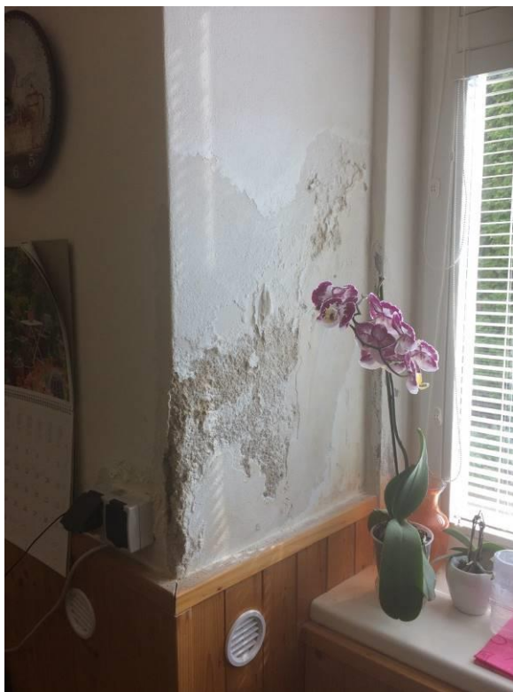
Místa jsou degradace omítek nad dřevěným obkladem zřejmé až do poloviny oken
