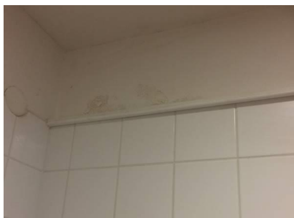
V prostoru sociálního zařízení je zřejmé, že vlivem provedení keramického obkladu vlhkost a soli vystoupaly až nad tento obklad
