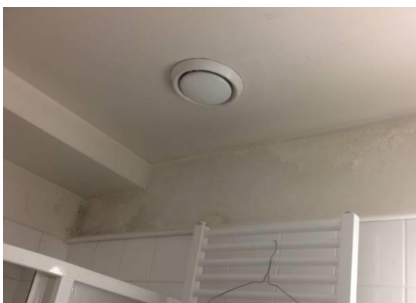
V prostoru sociálního zařízení je zřejmé, že vlivem provedení keramického obkladu vlhkost a soli vystoupaly až nad tento obklad
