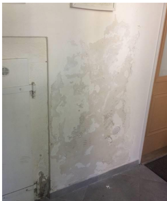
Místo největšího projevu vlhkosti na středním zdivu. Nebyla odhalena jiná příčina zavlhčení než vztlínající vlhkost. Osazené průduchy nemohou tak masivní zdivo odvlhčit. Původní omítky jsou silně zasolené, je nutné je vyměnit a provést pod nové omítky zapouzdření solí.
