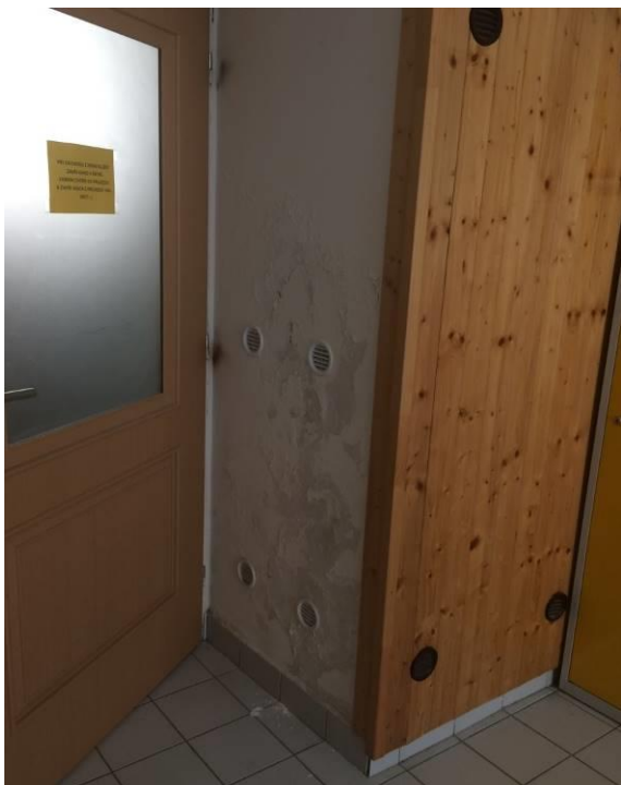
Projev vlhkosti je zřejmý i na druhé straně nejvíce zasažené konstrukce
