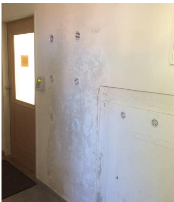
Místo největšího projevu vlhkosti na středním zdivu. Nebyla odhalena jiná příčina zavlhčení než vztlínající vlhkost. Osazené průduchy nemohou tak masivní zdivo odvlhčit. Původní omítky jsou silně zasolené, je nutné je vyměnit a provést pod nové omítky zapouzdření solí.
